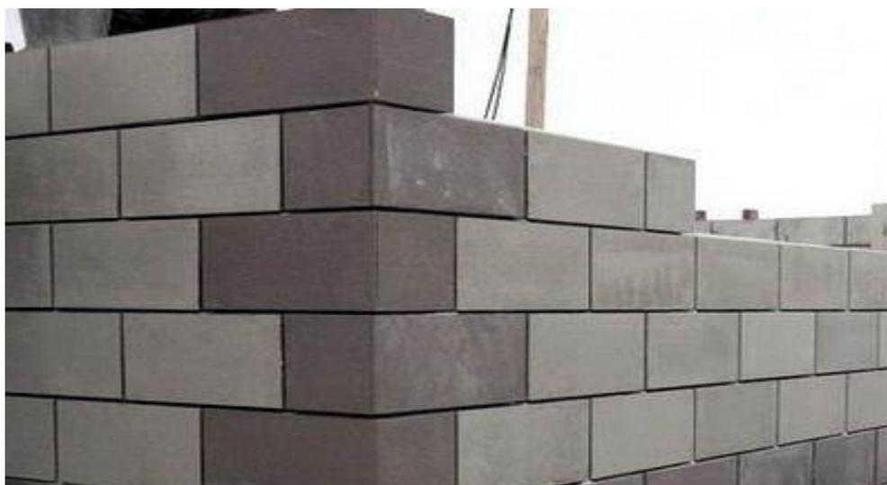
Рис.2. Кладка стен из полистиролбетонных блоков
