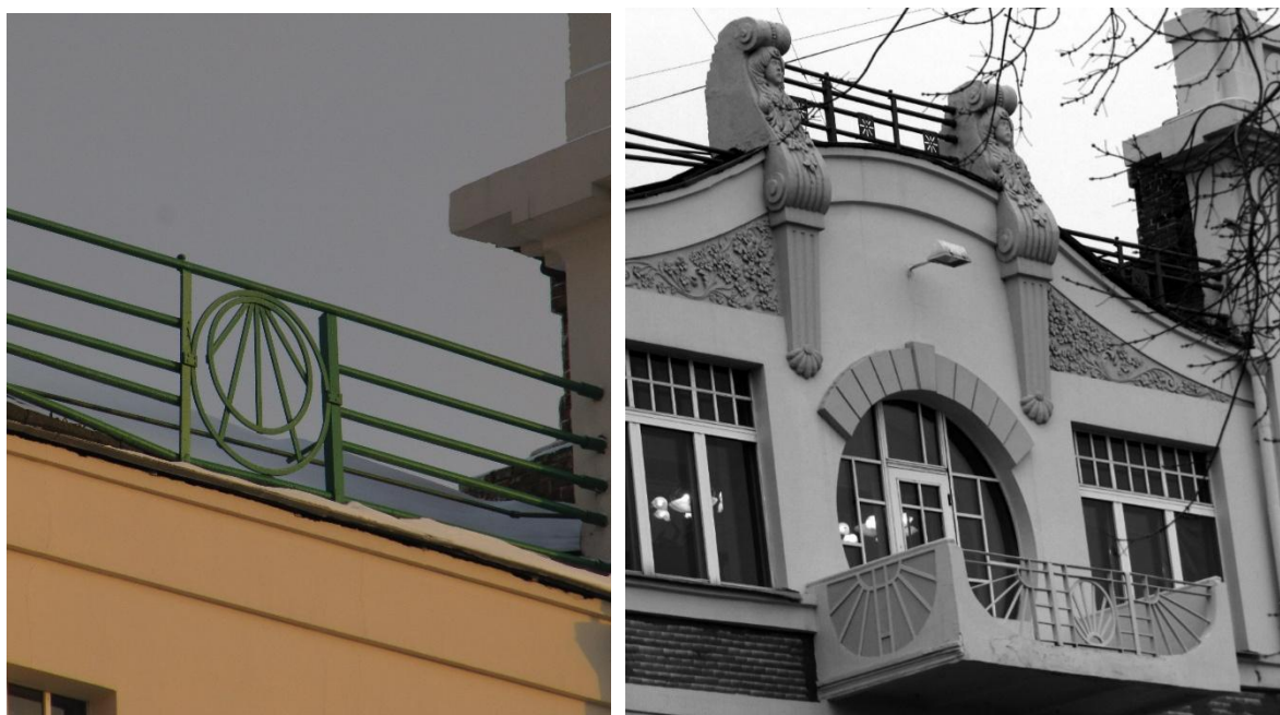
Рис.5. Здание конторы акционерного общества по продаже сельскохозяйственных машин «Р. и Т. Эльворти» (1913). Фрагмент фасада
