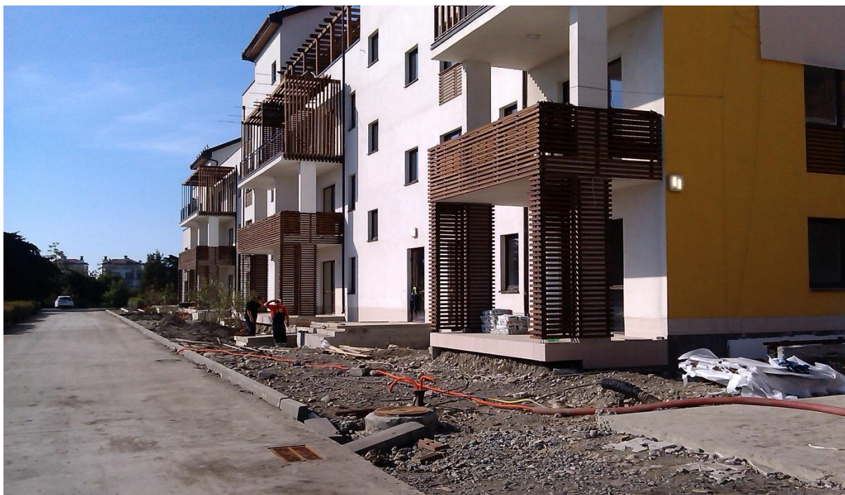
На фото: г.Сочи, Имеретинская низменность, Олимпийская деревня, Зона №8, Декоративное обрамление фасадов деревянными элементами из термодревесины
