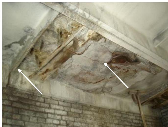
Рис.2. Плиты покрытия. Намокание, разрушение, поверхностные трещины в защитном слое бетона.
