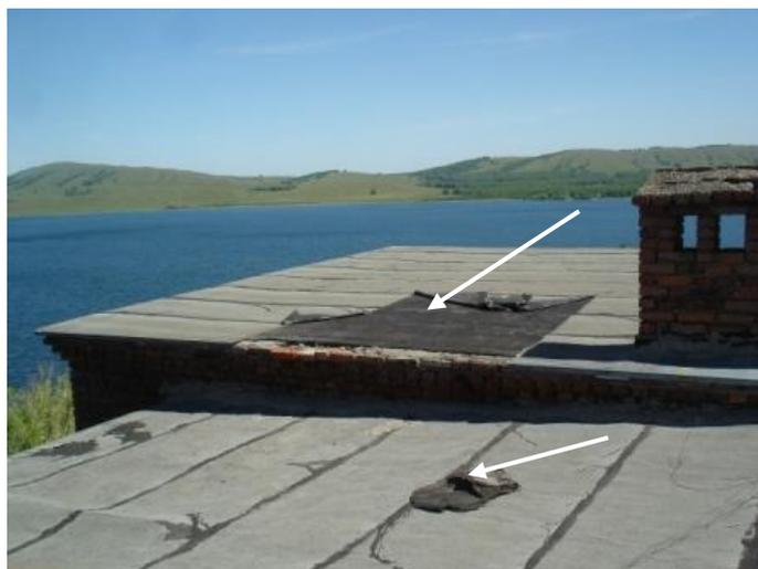
Рис.1. Нарушение целостности гидроизоляционного кровельного ковра в месте примыкания к частям здания.
