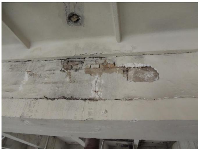
Рис.3. Разрушение прогона, вызванное воздействием влаги.
