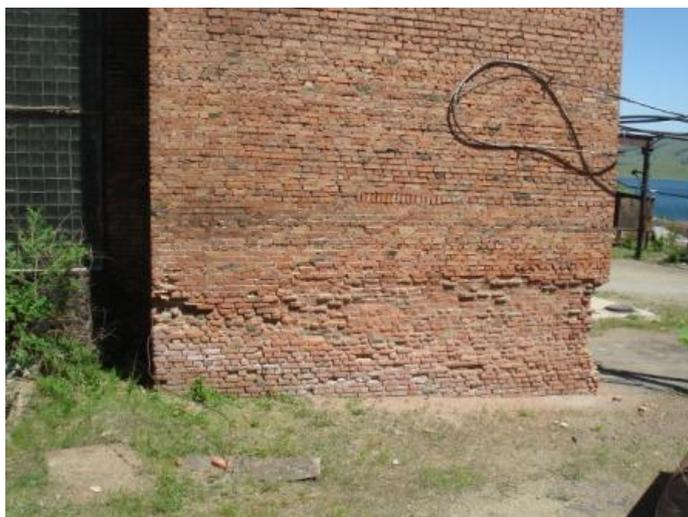
Рис.5. Разрушение кирпичной кладки стены котельной.
