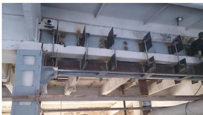
Рис.4. Усиление прогона.
