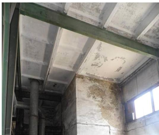
Фото 4. Следы замачивания от протечек кровли
