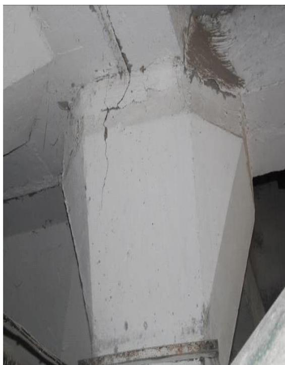
Фото 2. Наклонные трещины в капителях колонн
