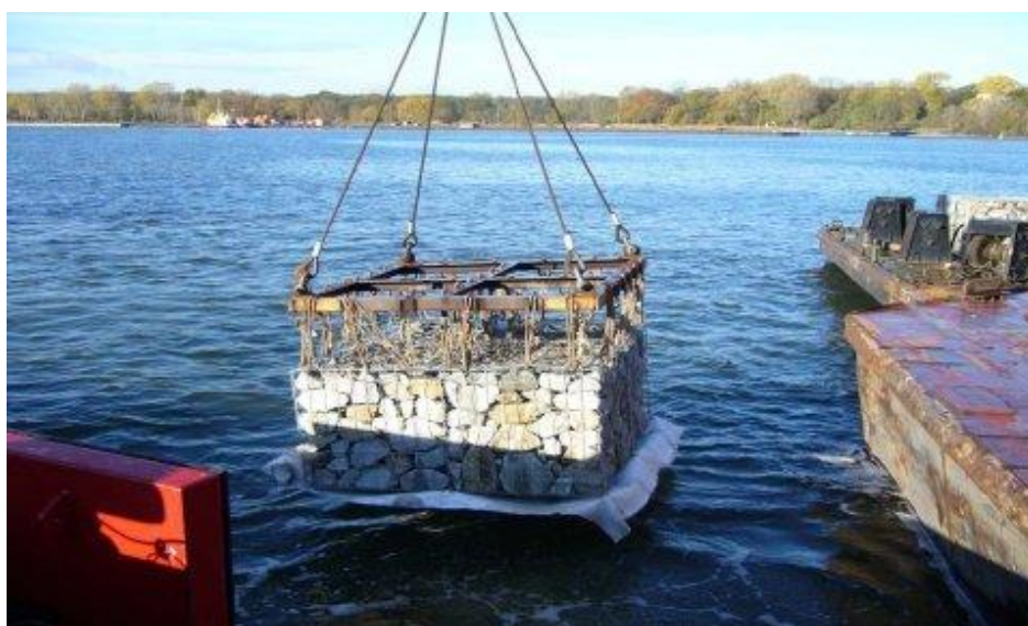
Рис.7. Габион выполненный из сварных каркасов
