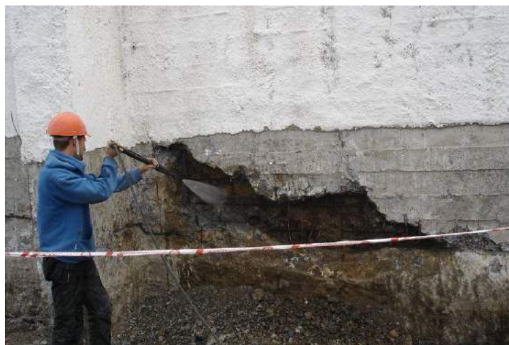
Рисунок 1 Разрушение ж/б конструкции, вследствие замачивания
